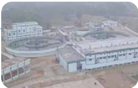
80 MLD WTP, UNNAO
