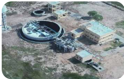
4 MLD STP, TONK
