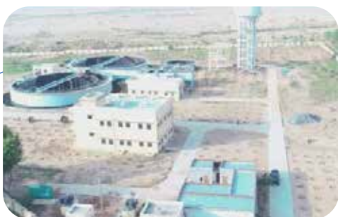
16 MLD STP, TONK
